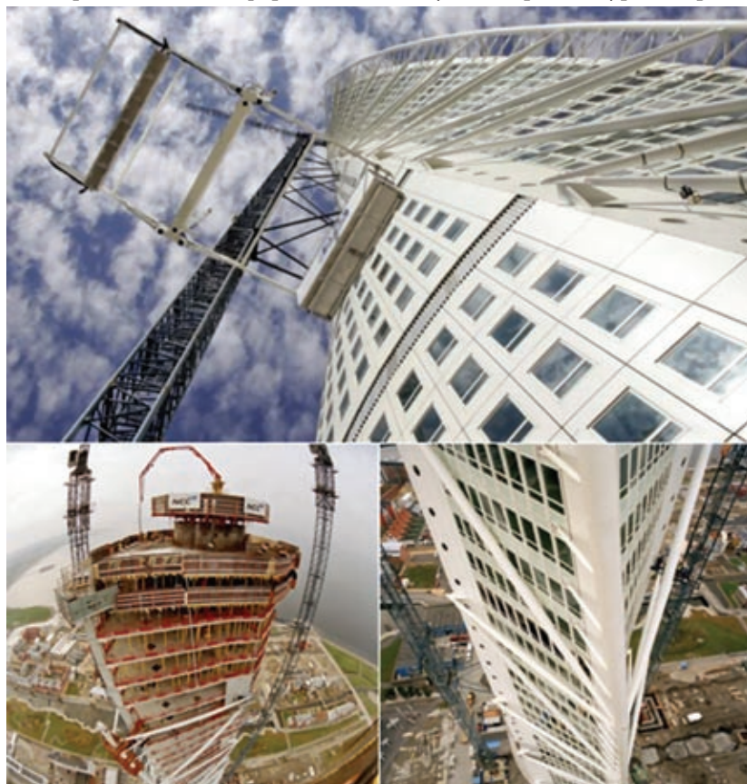
Уже в процессе строительства творение Калатравы производило сильное впечатление
