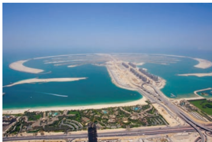
Примерно в таком состоянии первый искусственный остров пребывает в настоящее время
